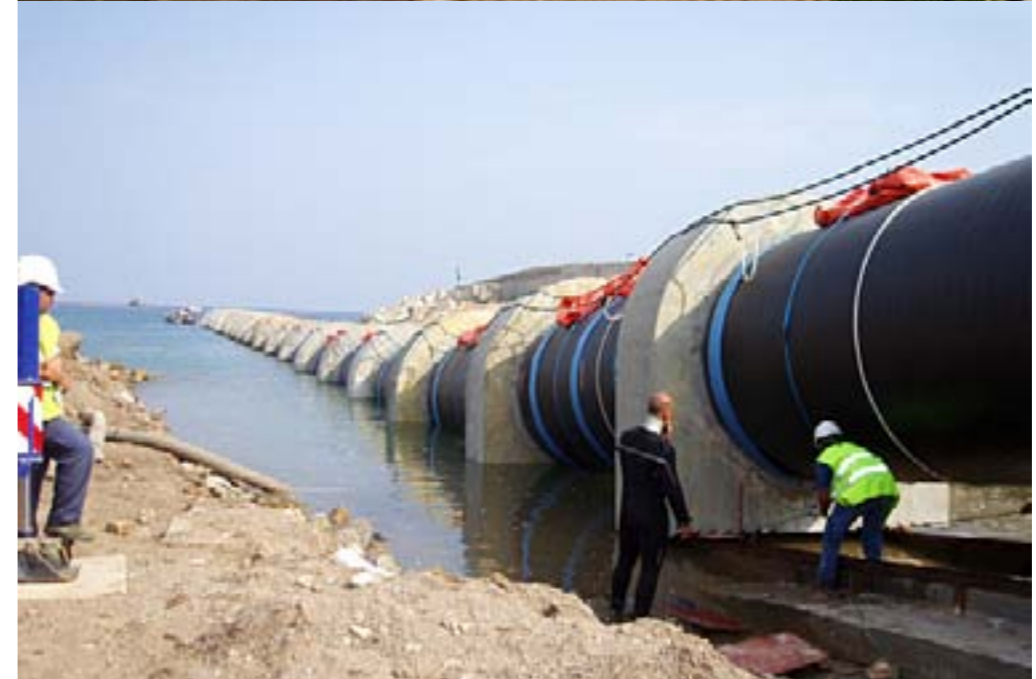
Arriba: vista panorámica de la desaladora de Torrevieja (Alicante). En el centro: trabajos de fondeo del emisario de la desaladora de Águilas (Murcia). Abajo: difusores del emisario submarino de la desaladora del Bajo Almanzora (Almería).
